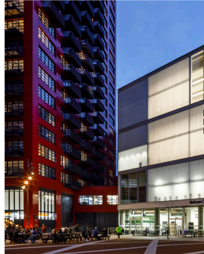
English National Ballet - Glenn Howells Architects RIBA Awards: RIBA Londres, Edificio del año 2021
